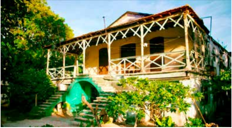
Casa de los Loynaz en ruinas
